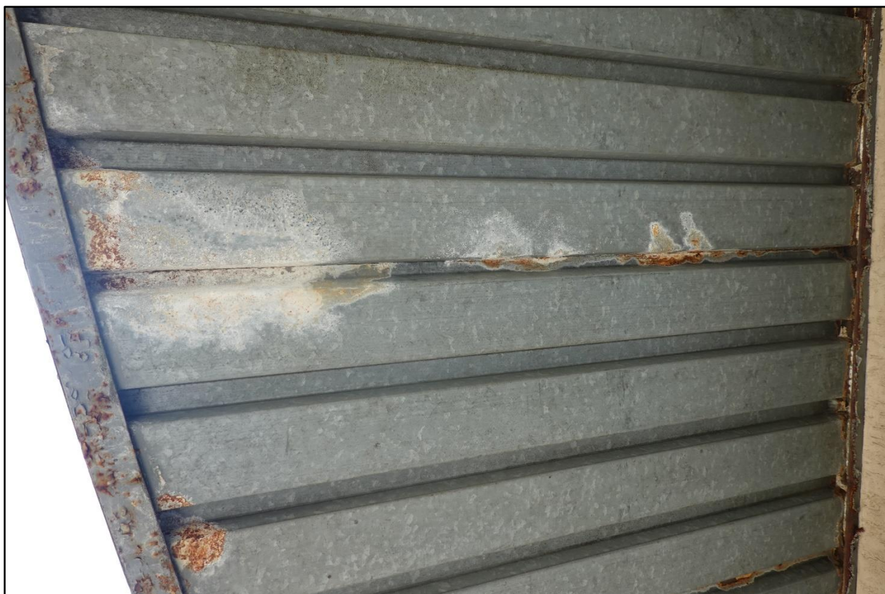
Fotografia 7 Powierzchniowe uszkodzenia obramowania stalowego oraz powłoki cynkowej na spodzie płyty balkonowej
