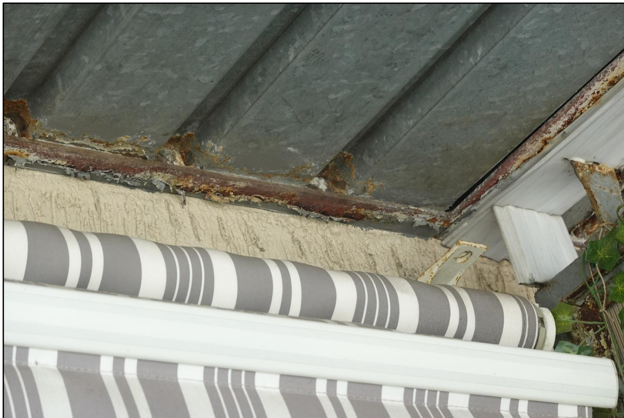
Fotografia 1 Obrazowanie płyty - powierzchniowe uszkodzenia powłoki malarskiej. Powierzchniowe uszkodzenia cynkowania blachy trapezowej
