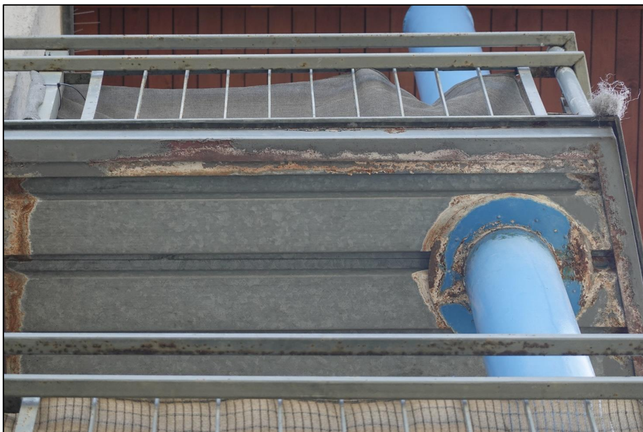
Fotografia 13 Balkony naroża budynku - uszkodzenia powłoki antykorozyjnej (malarskiej i ocynku) po obwodzie płyty balkonowej
