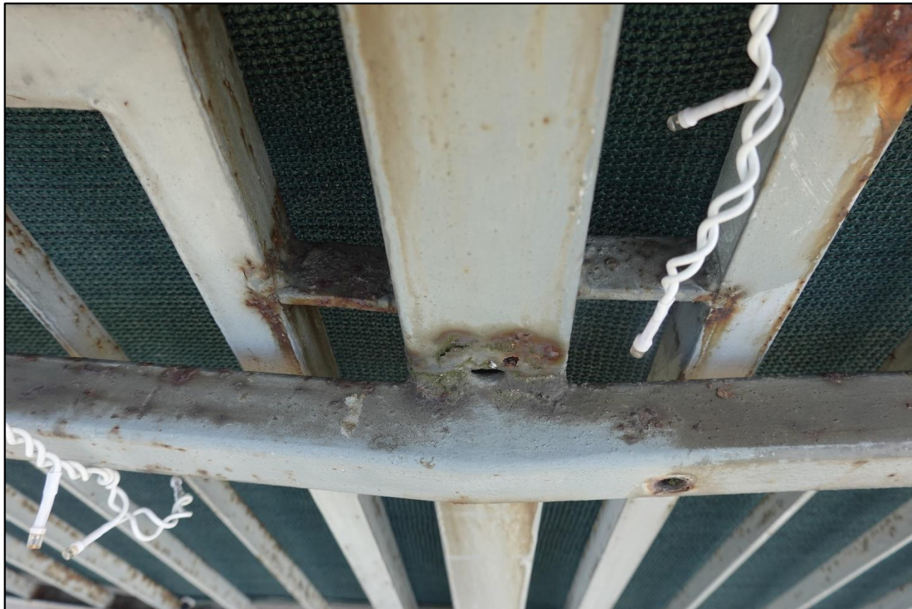
Fotografia 5 Korozyja balustrady
