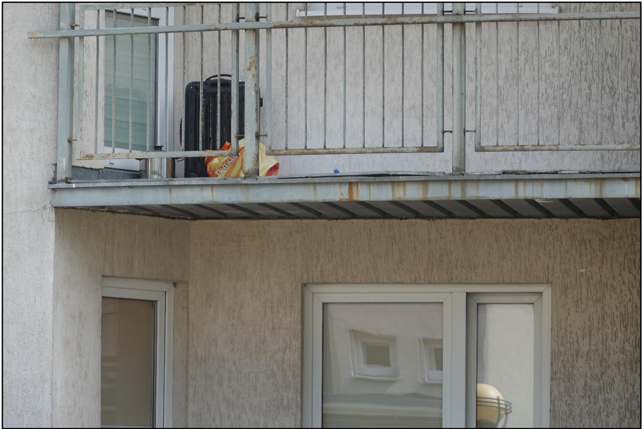
Fotografia 16 Zacieki na czole, uszkodzone płytki, odspojenia
