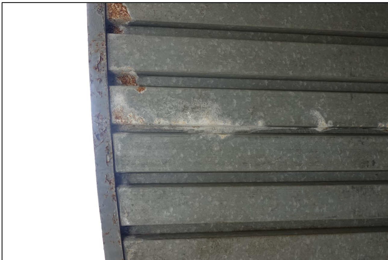
Fotografia 6 Powierzchniowe uszkodzenia obramowania stalowego oraz powłoki cynkowej na spodzie płyty balkonowej
