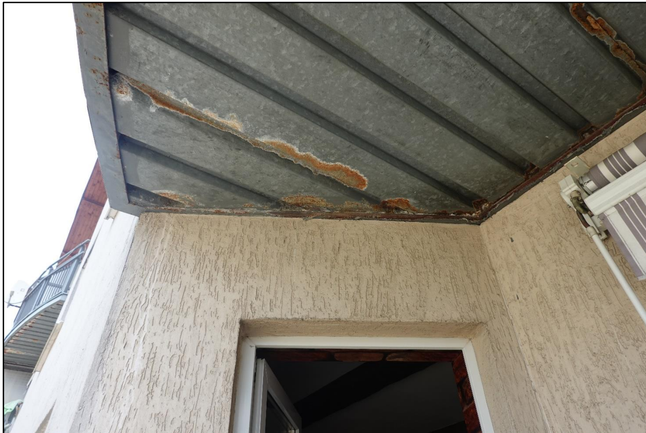
Fotografia 3 Obramowanie płyty - powierzchniowe uszkodzenia powłoki malarskiej. Powierzchniowe uszkodzenia cynkowania blachy trapezowej na końcach oraz połączeniu
