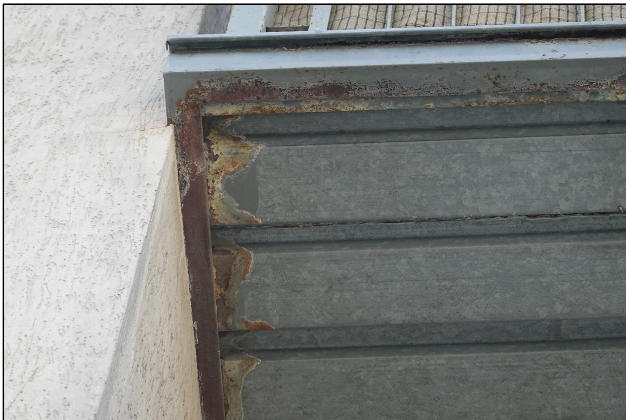
Fotografia 12 Balkony naroża budynku - uszkodzenia powłoki antykorozyjnej (malarskiej i ocynku) po obwodzie płyty balkonowej
