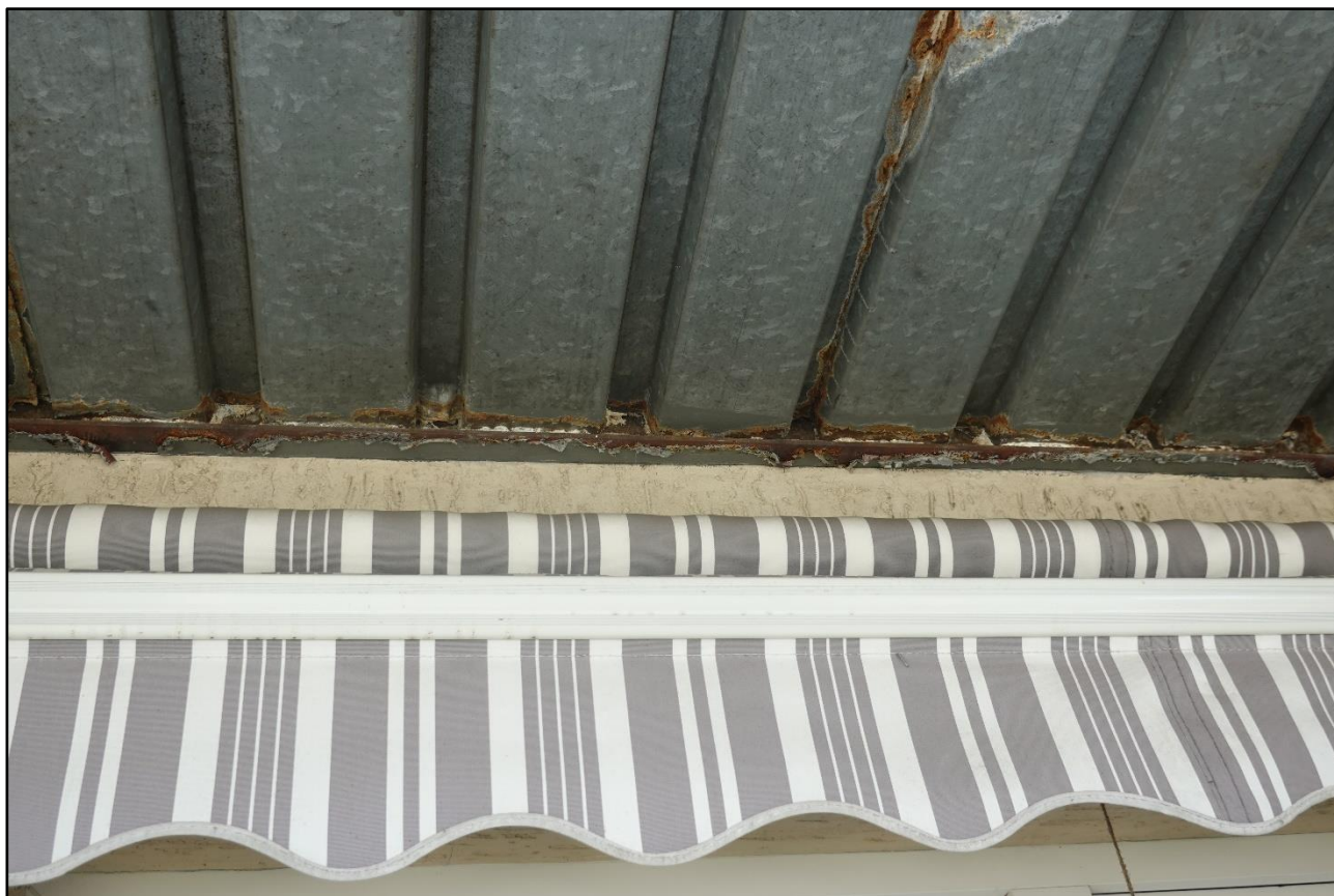
Fotografia 2 Obramowanie płyty - powierzchniowe uszkodzenia powłoki malarskiej. Powierzchniowe uszkodzenia cynkowania blachy trapezowej na końcach oraz połączeniu
