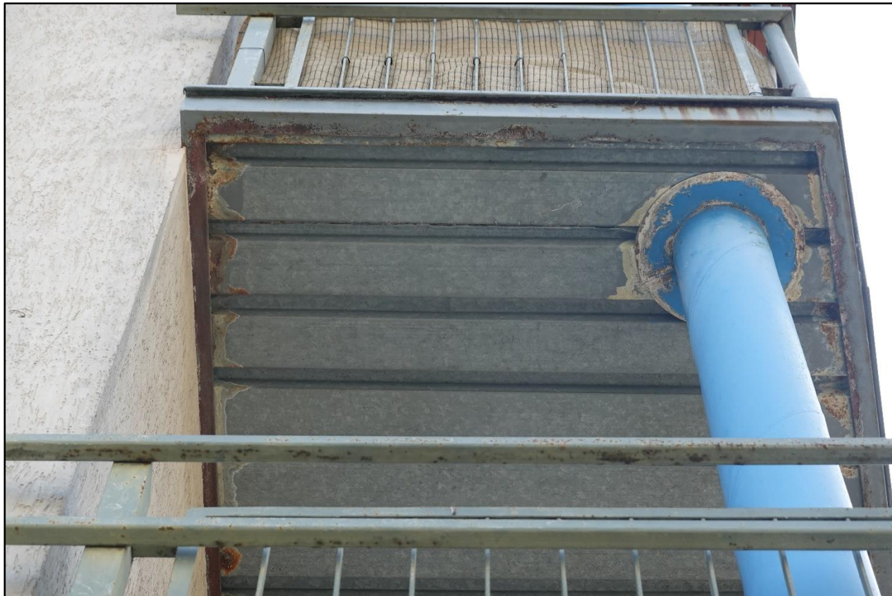
Fotografia 11 Balkony naroża budynku - uszkodzenia powłoki antykorozyjnej (malarskiej i ocynku) po obwodzie płyty balkonowej
