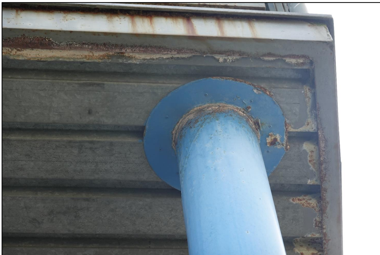
Fotografia 10 Balkony naroża budynku - uszkodzenia powłoki antykorozyjnej (malarskiej i ocynku) po obwodzie płyty balkonowej
