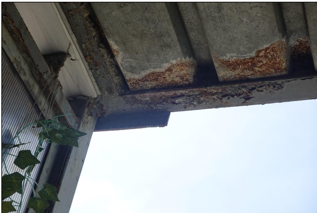
Fotografia 4 Obramowanie płyty - powierzchniowe uszkodzenia powłoki malarskiej. Powierzchniowe uszkodzenia cynkowania blachy trapezowej na końcach oraz połączeniu.
