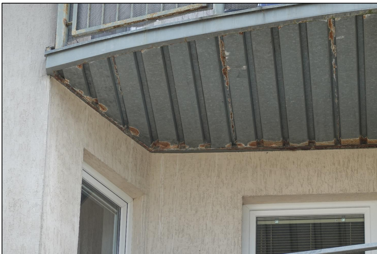
Fotografia 15 Uszkodzenia powłoki antykorozyjnej po obwodzie oraz na połączeniu blach trapezowych, korozja balustrady
