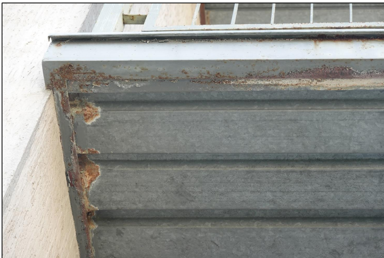
Fotografia 9 Balkony naroża budynku - uszkodzenia powłoki antykorozyjnej (malarskiej i ocynku) po obwodzie płyty balkonowej
